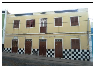
Antiga Residência pertencente ao Sr. Abrão Brigham
